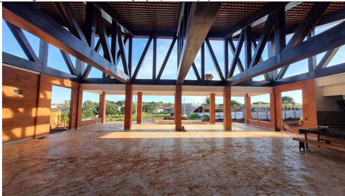
Figura 2 – Vista interna – espaço principal e estrutura (treliças metálicas).
